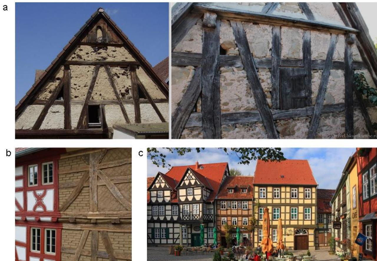
**Рисунок 32** – Фахверковый дом: а – заполнение деревянного каркаса хаотичной каменной кладкой; б – заполнение каркаса кирпичной кладкой; с – вид фахверковой застройки исторических городов Центральной Европы (фото из свободного доступа)
