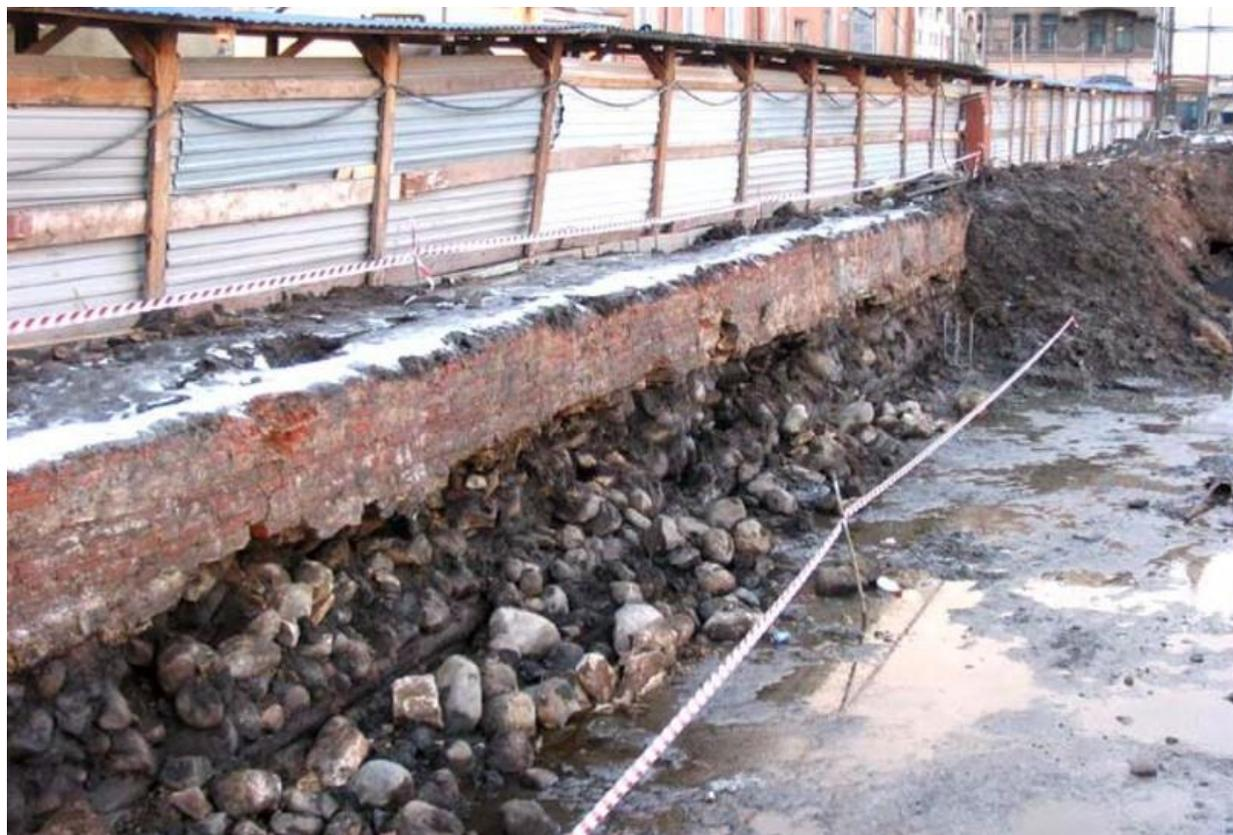
Рисунок 16 – Вид вскрытого бутового фундамента с деревянными лежнями одного из петербургских строений по Казачьему переулку и Литейному проспекту, 24 [18]
